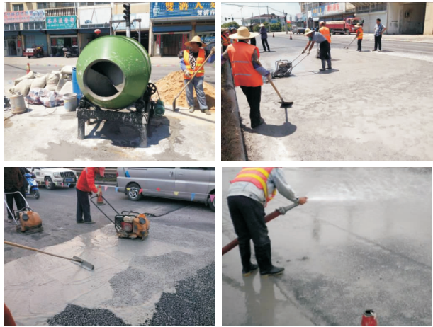
图 1 灌入材料施工现场
