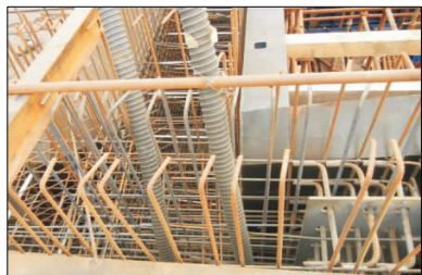
图 3 波形钢腹板贯穿通长钢筋设计
