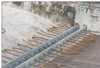
图 4 Twin—PBL 连接件局部加强部位
