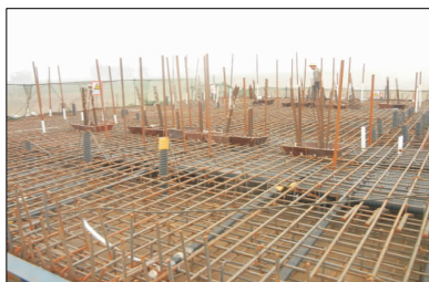
图 6 现浇 0 # 、1 # 块一次浇筑成型
