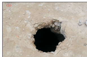
图6 K76+175 左 9 m 落水洞
