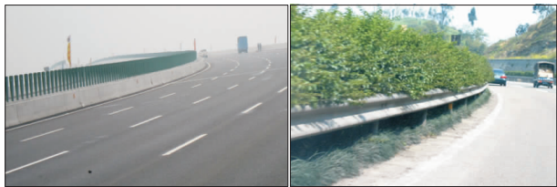
图 1 中央分隔带视距不足实例图
