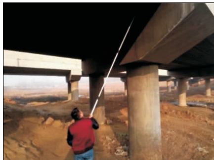
图4 云相机+伸缩杆方式观测支座
