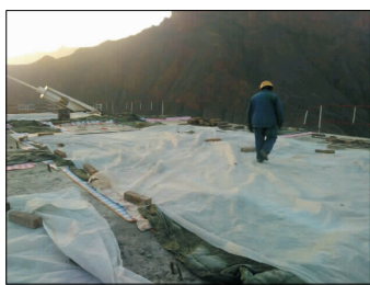
图 3 湿接缝砼养护现场
