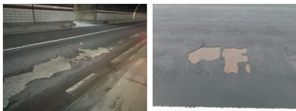
图 2 国内其他公司薄层环氧面层脱落情况
