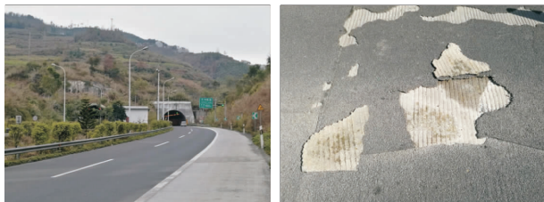
图 1 G78 隆百段隧道铺装薄层环氧罩面照片
