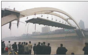
图 2 某中承式拱桥桥面坍塌现场
