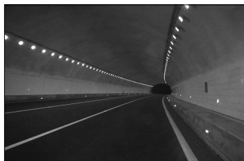
图5 隧道内有源轮廓标
