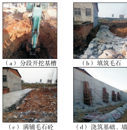
图 2 新建挡土墙基础的施工过程
