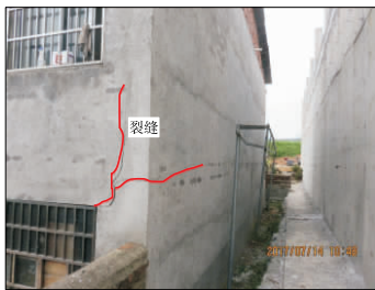
(b) 北墙裂缝
