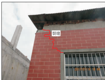
(a) 南墙裂缝
