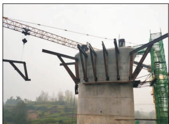
图8 装配式牛腿安装
