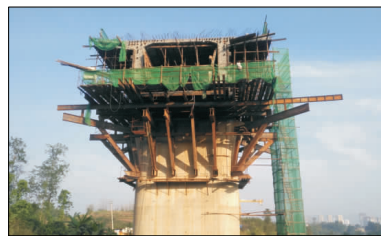
图10 施工完毕的0#块
