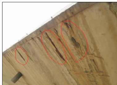
图 1 下游侧翼板破损
