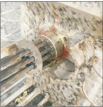
图 2 封锚罩的安装
