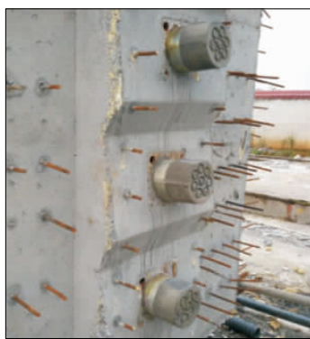
图5 拆模完成
