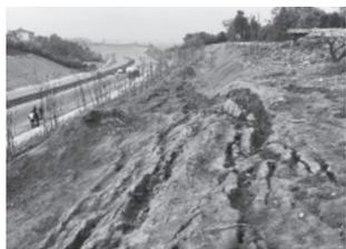
(b) 坡率降至 1:2 且完成路面铺筑后再次滑坡
