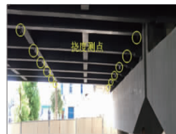
(b) 主梁跨中挠度测点布置
