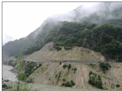
图8 施工完成后边坡
