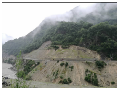
图8 施工完成后边坡
