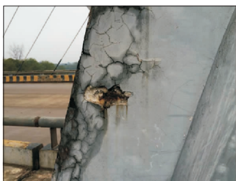
图2 拱肋破损
