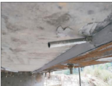
图10 安装注浆管
