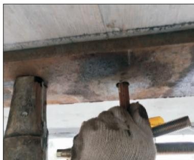
图6 钻孔螺杆植埋
