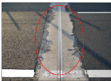
图5 伸缩缝锚固区破损
