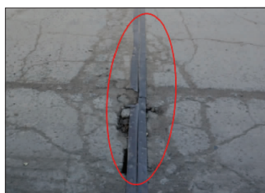
图6 伸缩缝钢板断裂
