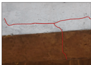
图11 主梁裂缝
