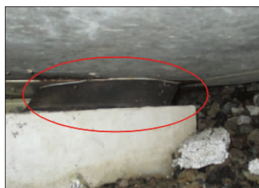
图7 支座剪切变形
