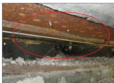
图8 支座钢板锈蚀
