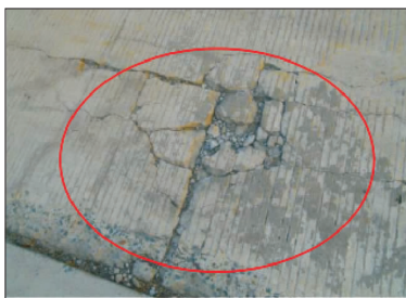
图3 桥面破损
