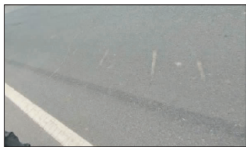
图 15 桥面铺装刮擦、凹槽
