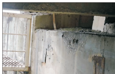
图 13 8#桥墩盖梁破损
