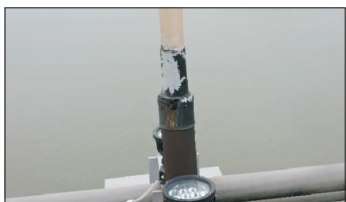
图4 吊杆热缩带腐蚀、破损
