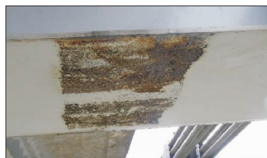
图 12 桥面板横梁底面局部油漆脱落、锈蚀
