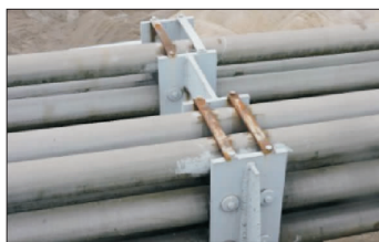
图9 系杆限位钢条锈蚀
