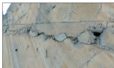
图 14 拱座砼破损
