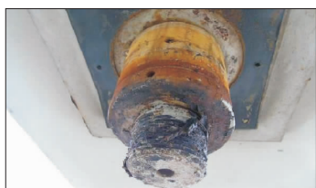
图7 下锚头黄油老化
