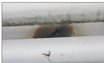
图8 系杆保护套表面破损
