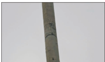
图5 吊杆外护套表面老化、开裂
