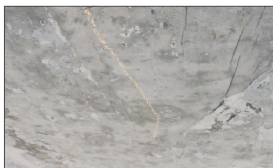
图 11 桥面板纵向裂缝
