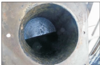
图6 锚杯内积水
