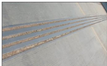
图 16 伸缩缝堵塞
