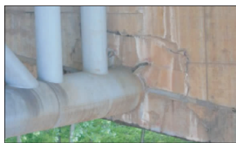
图 2 边跨砼破损、锈胀
