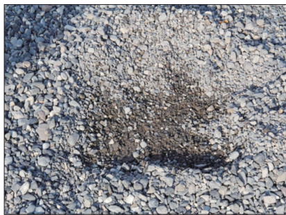
图 3 K116+000 处避险车道制动坡床
