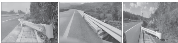
(a) 端头外展斜率不足 (b) 未设置刚柔过渡 (c) 护栏与边坡存在间隙
