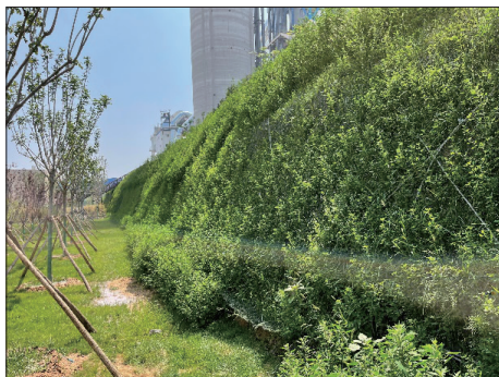
图1 边坡柔性面层土钉支护效果
