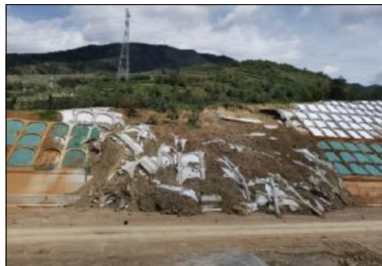
图8 昭通昭阳高速公路 K11+500—570 右侧滑坡
