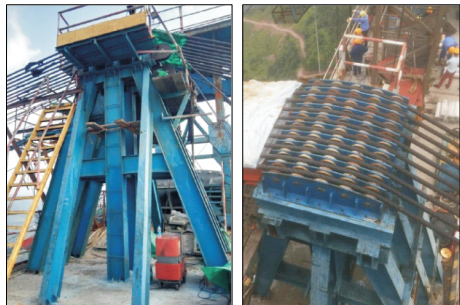
图3 塔顶支架及索鞍示意图
