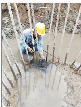
图 5 超声波检测管注浆
