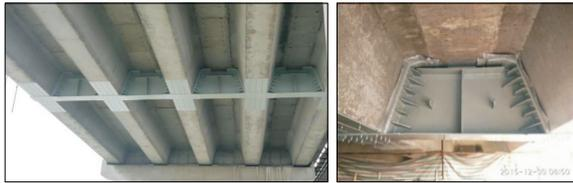
图 4 钢板横隔梁加固效果
