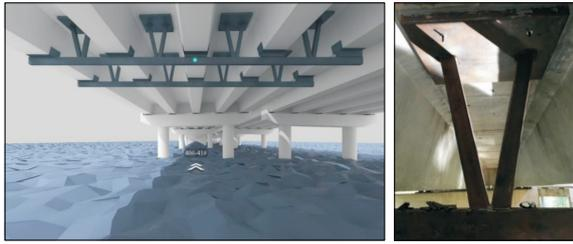
图 3 钢桁架横隔梁加固效果
