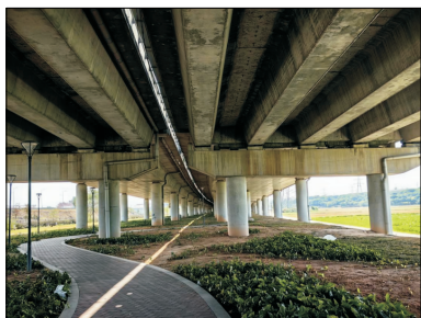
图 6 从莞(从化—东莞)高速公路东莞市横沥镇村头村葵花园路段桥下空间用作景观绿化美化
