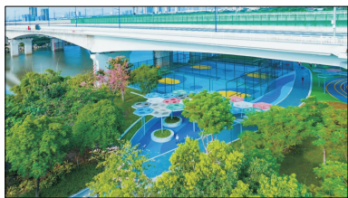
图 3 佛山市顺德区陈村镇广佛环线桥下空间整治提升工程
