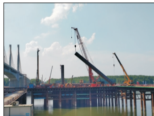
图 14 钢护筒的起吊和放下
