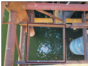
图 9 导向架的安装
