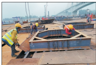
图 8 导向框的安装
