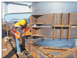
图 15 钢护筒节段的现场拼接
