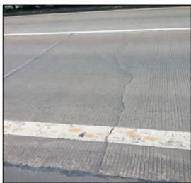
(a) 典型裂缝板
