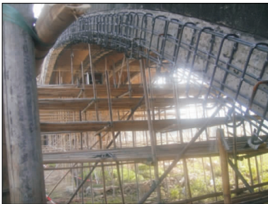
图 3 拱肋增大截面钢筋骨架
