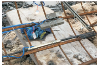
(b) 钢筋计安装于钢筋笼
