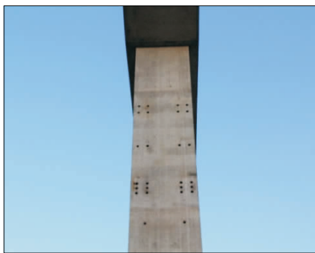
图9 爬锥拆除后的工程照片
