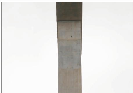
图10 爬锥孔砼修补完成后的工程照片
