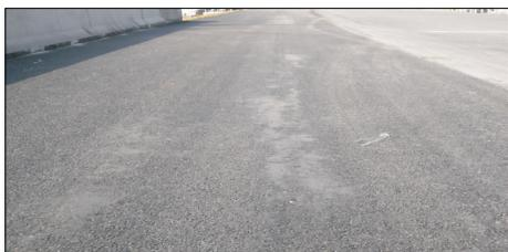
图 7 使用 K 纤维较差的铺筑效果
