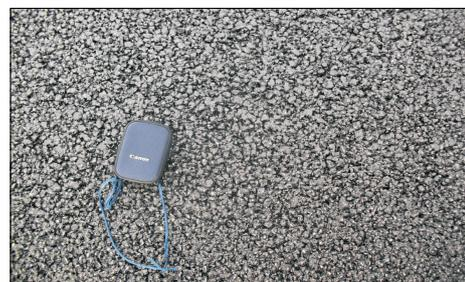
图 6 使用 K 纤维较好的铺筑效果
