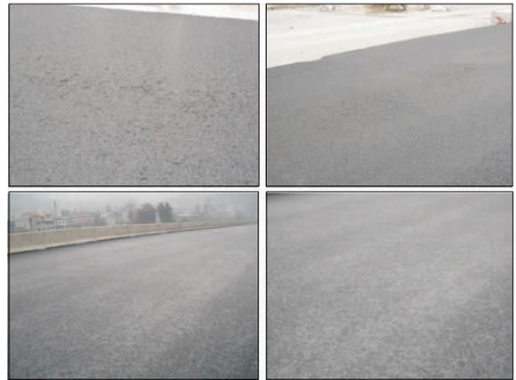
图 4 使用国产絮状纤维 N 的 SMA 经碾压后泛油
