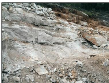
图6 齿墙基底清理
