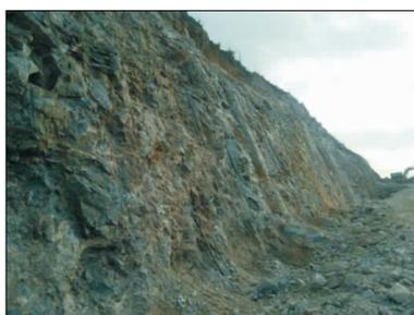
图5 水压爆破后坡面控制情况
