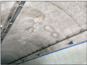
图 1 右洞拱顶纵向裂缝
