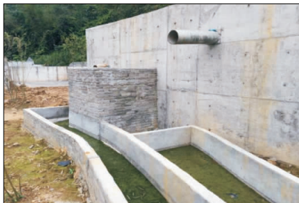
图7 中山顶隧道洞口引排设施
