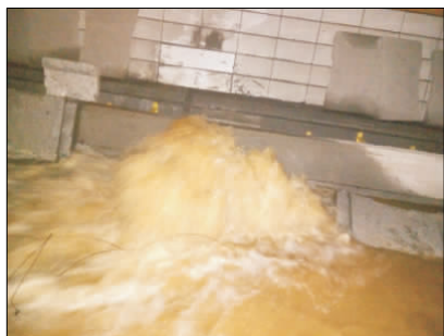
图6 中山顶隧道检查井涌水
