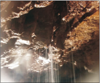
图 3 大瑶山 1 号隧道洞内涌水
