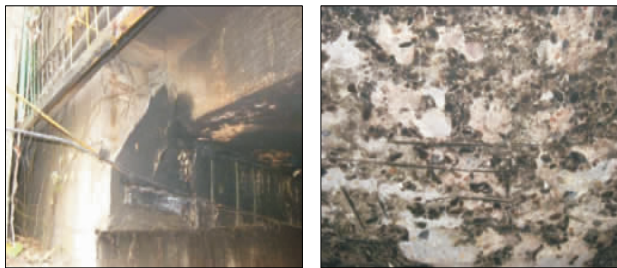
图 1 某钢筋砼梁桥火灾现场
