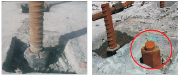
图 3 锚具反装和钢筋外露长度过短
