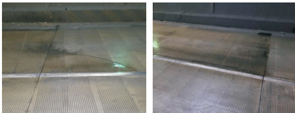
图 1 大端、潮水隧道路面渗水状况
