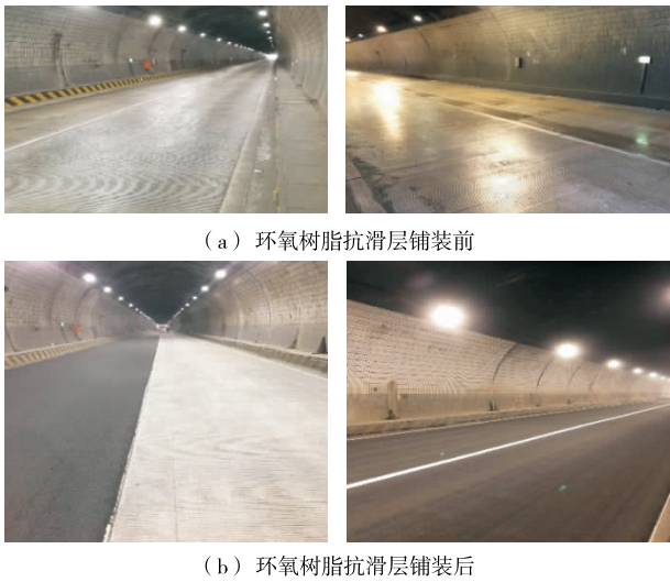
图 4 环氧树脂抗滑层铺装前后的路面
