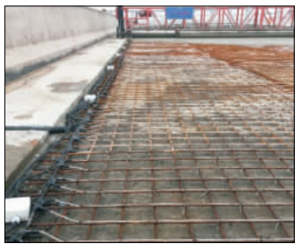
图 4 电源接线和套护管
