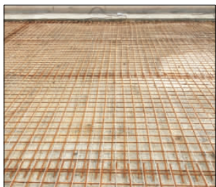
图 3 碳纤维发热线布设
