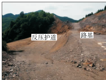
图3 施工中的路基
