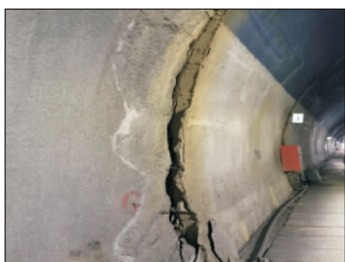
图 2 水压过大引起衬砌开裂错台
