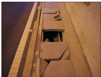
图8 检修道盖板断裂、缺失
