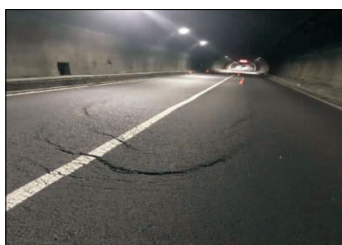
图 5 路面存在裂缝
