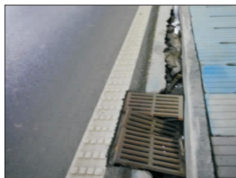
图 4 排水设施损坏且堵塞
