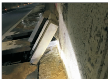
图 3 边墙喷射状渗水
