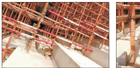
图6 接高套筒及台阶使用情况(未完工状态)
