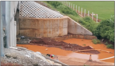
图 2 某桥下改路积水
