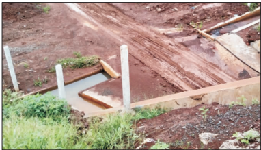
图 1 涵洞口积水排不出
