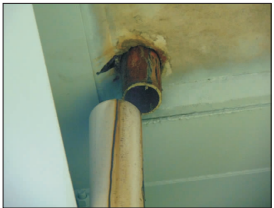
(b) 排水管与泄水管脱开错位
