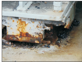
(b) 支座钢构件严重锈蚀
