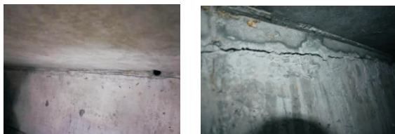
图3 箱梁腹板与倒角交界面箱内裂缝
