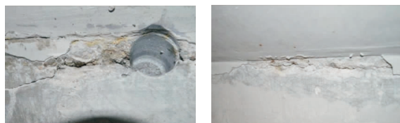
图 2 箱梁腹板与倒角交界面箱外裂缝
