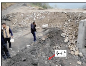
图 3 挡土墙处裂缝现状
