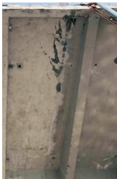
图 1 主梁翼缘裂缝分布
